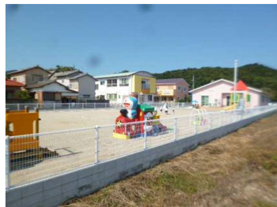
こじか保育園運動場フェンス及び造成工事
